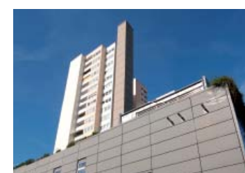
Fernwärmeversorgung nach den neuesten Erkenntnissen ökologischer Energiewirtschaft: Das Blockheizkraftwerk im Stadtteil Buch.
