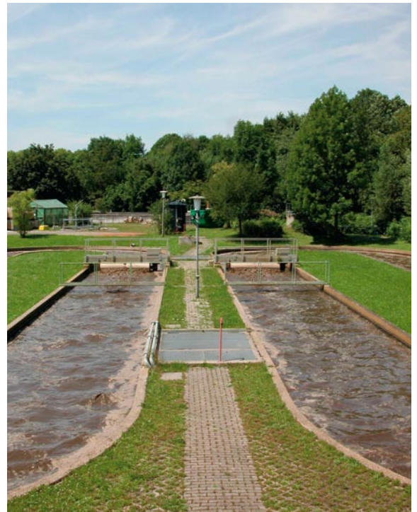
Kläranlage Freudental, Belebungsbecken
